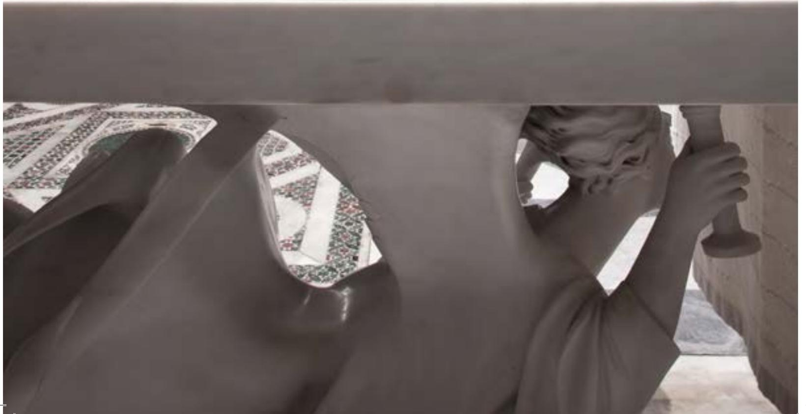
L'intervento ha comportato la posa in opera di nuove porzioni di cornici laddove mancanti; dopo il necessario consolidamento, sulle rimanenti cornici si è proceduto alla stuccatura e al raccordo delle varie parti mediante l'uso di idonei prodotti di colore identico a quello della pietra esistente.
